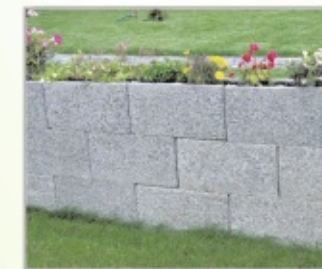
Строительство поддерживающих стен
