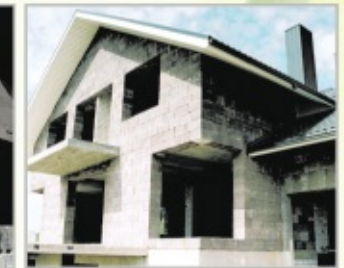
Угловые окна без опор
